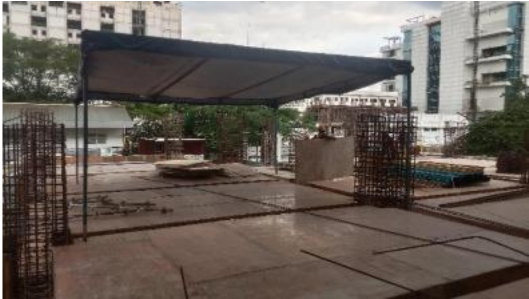
Gambar 3.131 Penggunaan Tenda Terpal pada Pembesian Balok Lantai 2
