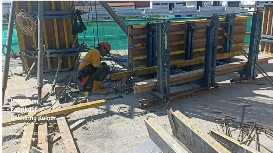
Gambar 3.70 Fabrikasi Bekisting Kolom
