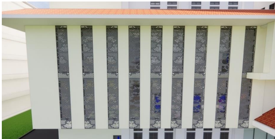
Gambar 3.94 Pekerjaan Sealant dan Pembukaan Proteksi ACP
