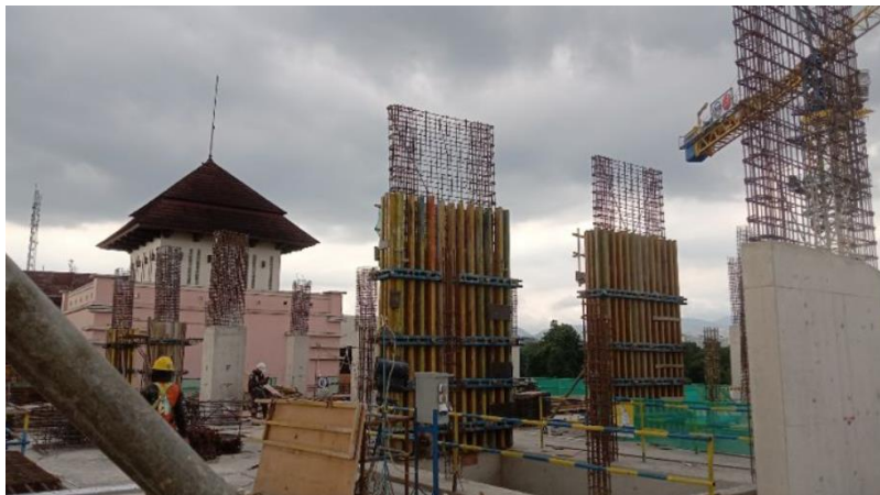
Gambar 3.78 Pemasangan Bekisting Dinding Geser
