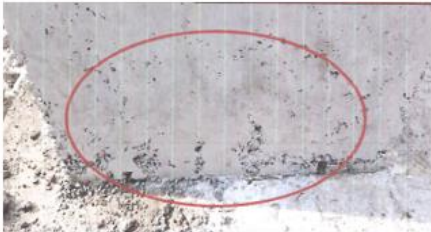
Gambar 3.118 Temuan Bagian Bawah Kolom Keropos
