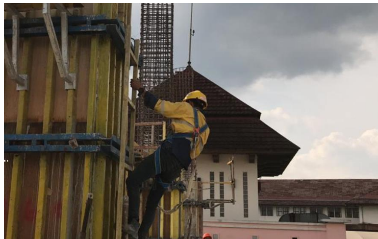
Gambar 3.74 Pembongkaran Bekisting
