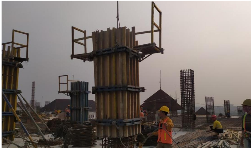
Gambar 3.72 Instalasi Bekisting Kolom
