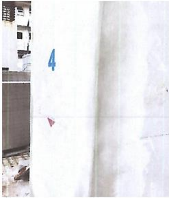
Gambar 3.121 Temuan dan Perbaikan Kolom Gompal
