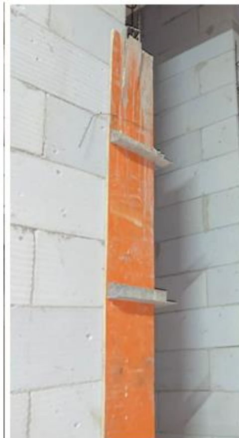
Gambar 3.125 Penggunaan Bekisting Knockdown
