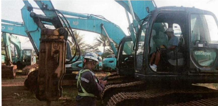
Gambar 3.108 Pre Mobilisasi Excavator
