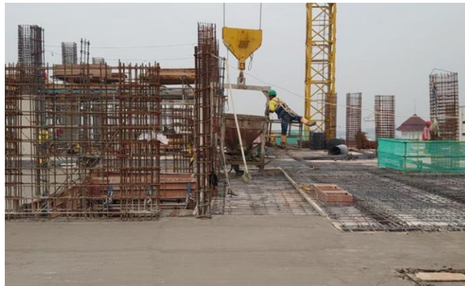
Gambar 3.64 Pengecoran Balok
