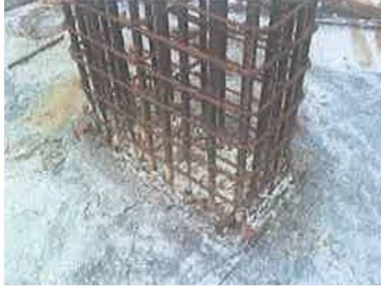
Gambar 3.68 Pemasangan Sepatu Kolom
