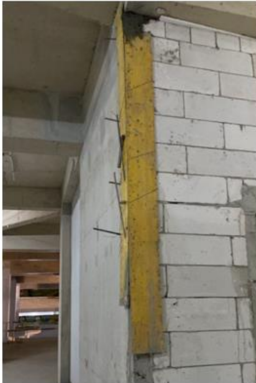
Gambar 3.124 Penggunaan Bekisting Multiplek Konvensional
