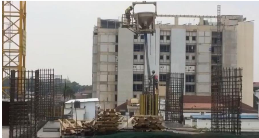
Gambar 3.73 Pengecoran Kolom
