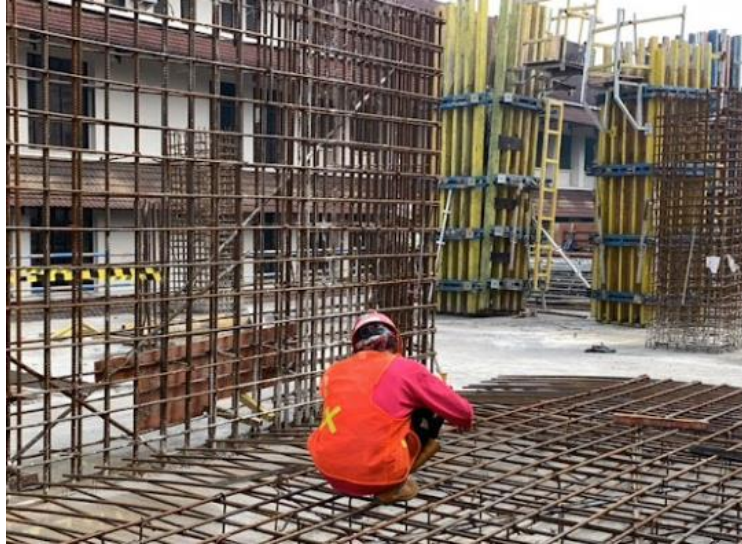
Gambar 3.77 Pemasangan Tulangan Dinding Geser
