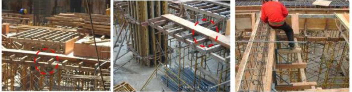
Gambar 3.62 Pemasangan Bekisting Balok
